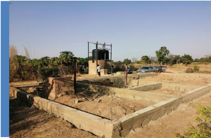
Construction du local à Dawanagomé
