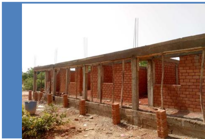
Construction du local à Dawanagomdé
